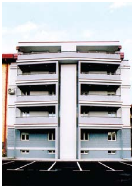
Stambena zgrada u Boška Petrovića 7a, Beograd
